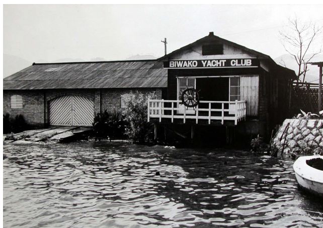
再建されたBYC艇庫
